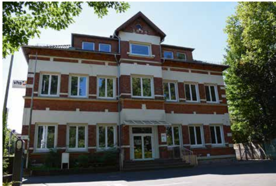
Schulungsgebäude der vhs in Dissen Foto: vhs Osnabrücker Land
